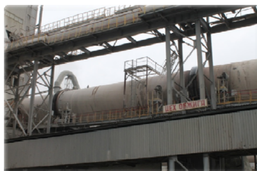
Рисунок 2 – Цех обжига клинкера на Белорусском цементном заводе
